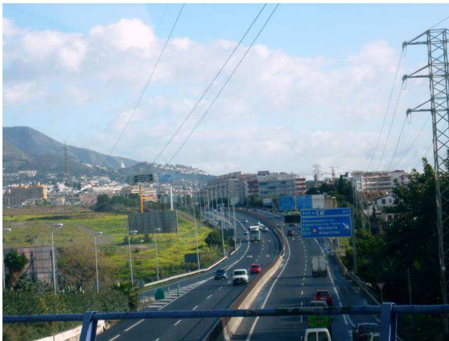
Autovía A-7 vista desde la intersección con el acceso a la carretera A-387
