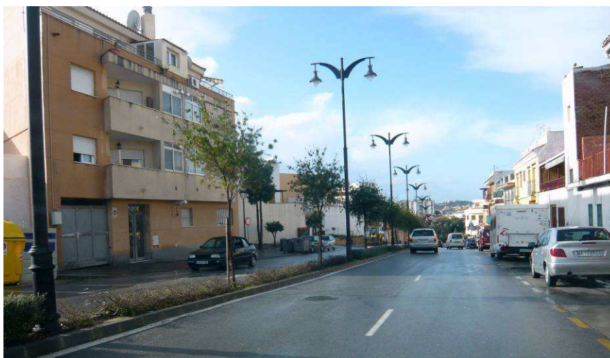
Camino de Campanales tramo 1 entre la A-387 y la Avda. de Mijas.
