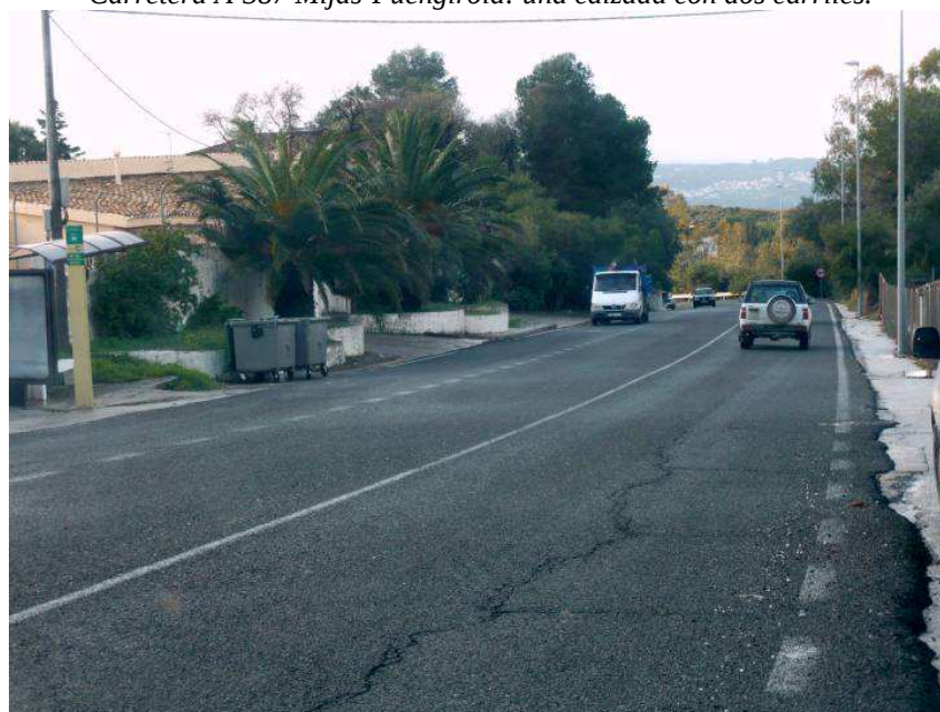
Carretera A-387 Mijas-Fuengirola: una calzada con tres carriles.
