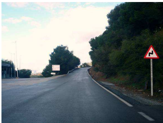
Acceso a la carretera A-368 desde la intersección con la autovía A-7.
