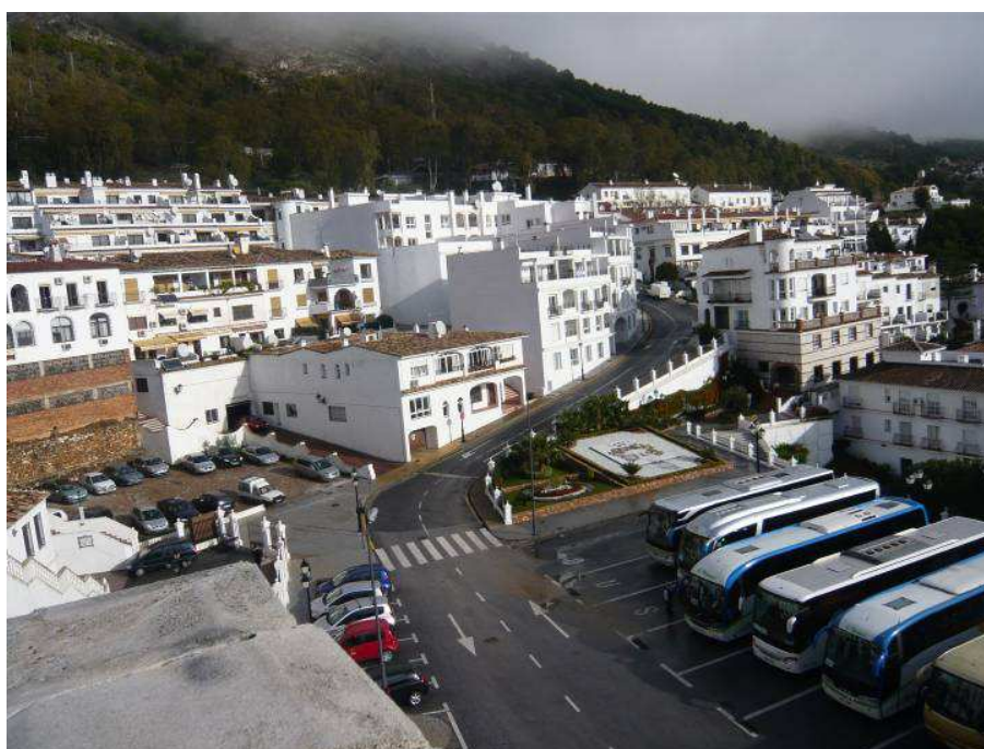
Vista aparcamiento de autobuses y Avenida Virgen de la Peña.
